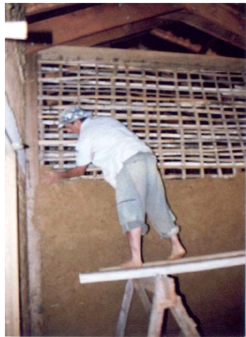
Figura 9 – Prensamento da argamassa de barro na trama. Fonte: Canteiro (2005)
