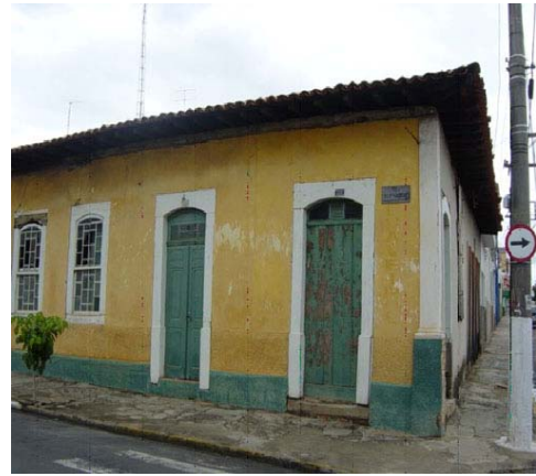
Figura 1 - Residência de taipa de mão construída no início do século XX– Itu/SP Fonte: Pisani (2005)
