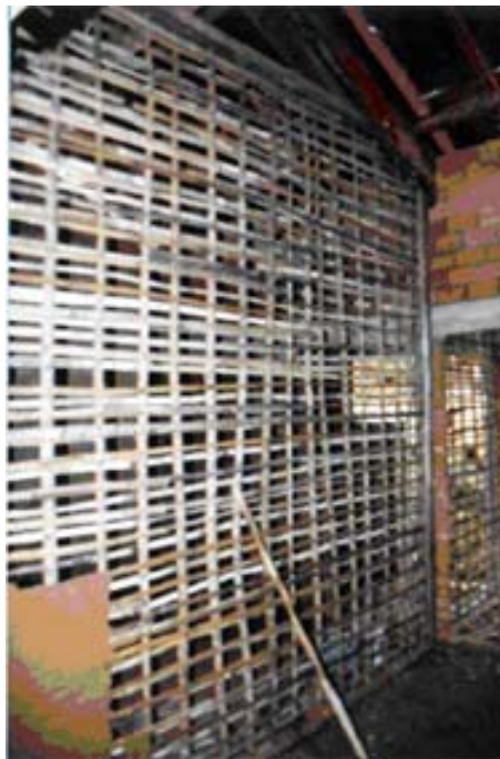
Figura 8 – Estrutura de madeira da taipa de mão. Fonte: Canteiro (2005)
