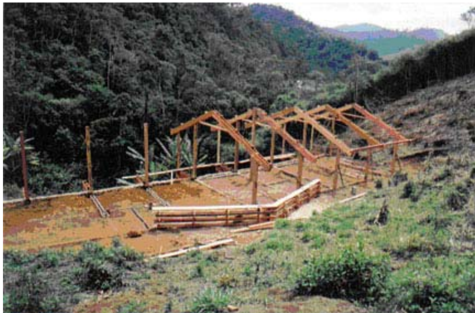
Figura 7 – Estrutura de madeira. Fonte: Canteiro (2005)
