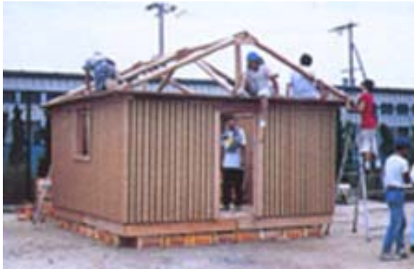
Foto 5 – Abrigo em construção em Kobe, Japão. Fonte: The Japan Architect, Summer 1998, p. 89.
