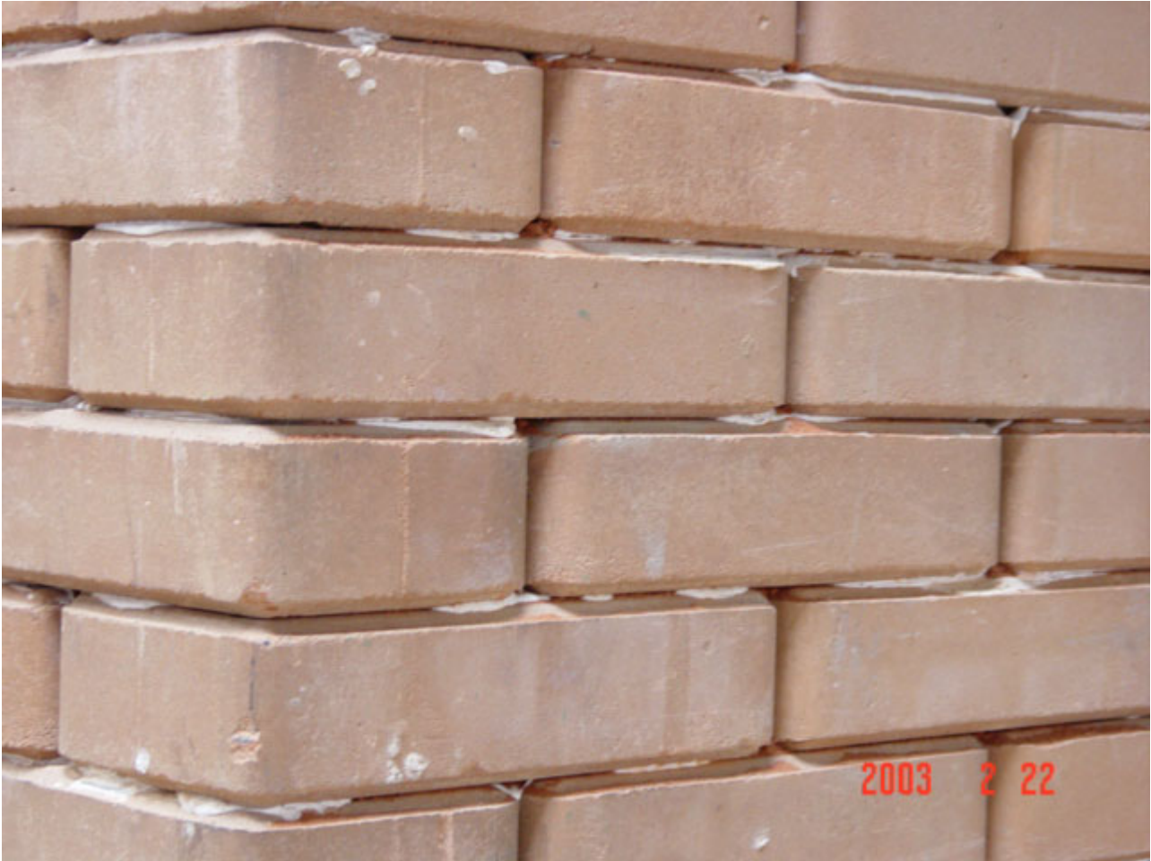
Foto 3 – cunhal de alvenaria de tijolo de solo-cimento à vista, assentados com cola de PVA.
